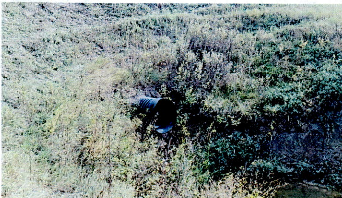
PE spillway outlet
