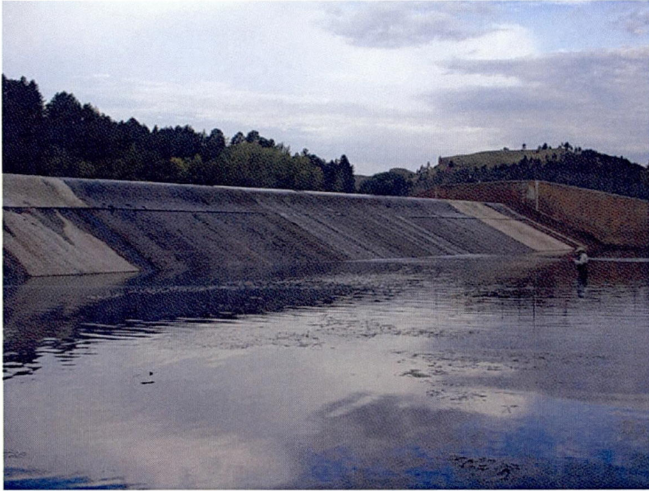
Canyon Lake spillway 9-15-2006
