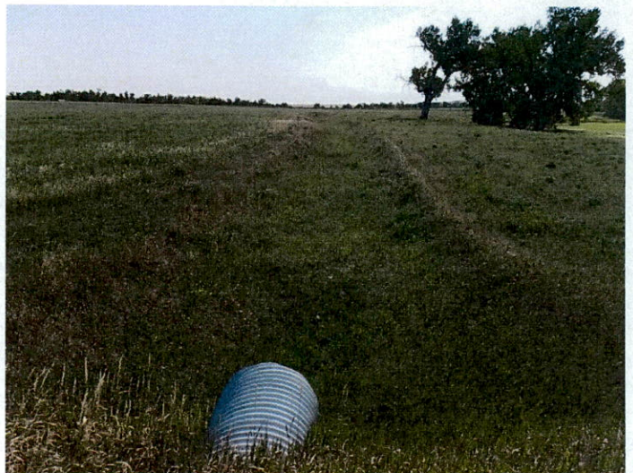
diversion ditch (NW \frac{1}{4} NE \frac{1}{4} S13)
