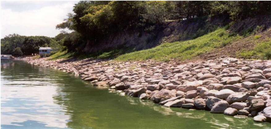
Rock Rip Rap
